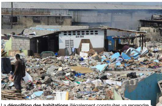
La démolition des habitations illégalement construites va reprendre.
